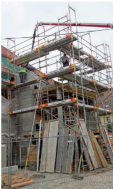
Im Anschluss wurde der Anbau mit den Fertigbetonbauteilen aufgerichtet.
