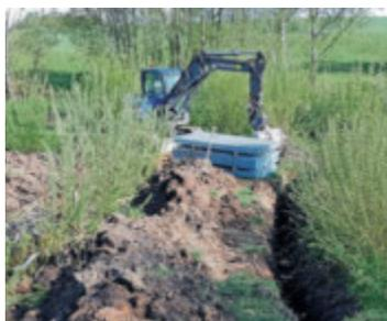
Einbau der Stabmattensperre ins Erdreich des Damms
