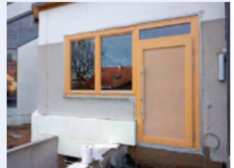
Auf der Nordseite wurde der neue Zugang für die Sakristei hergestellt. Zusätzlich erhält die Sakristei einen Vollwärmeschutz.
