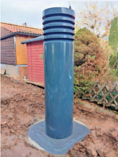
Über den Lüftungsturm an der Nordseite wird die Lüftungsanlage für das Bürgerzentrum bedient.
