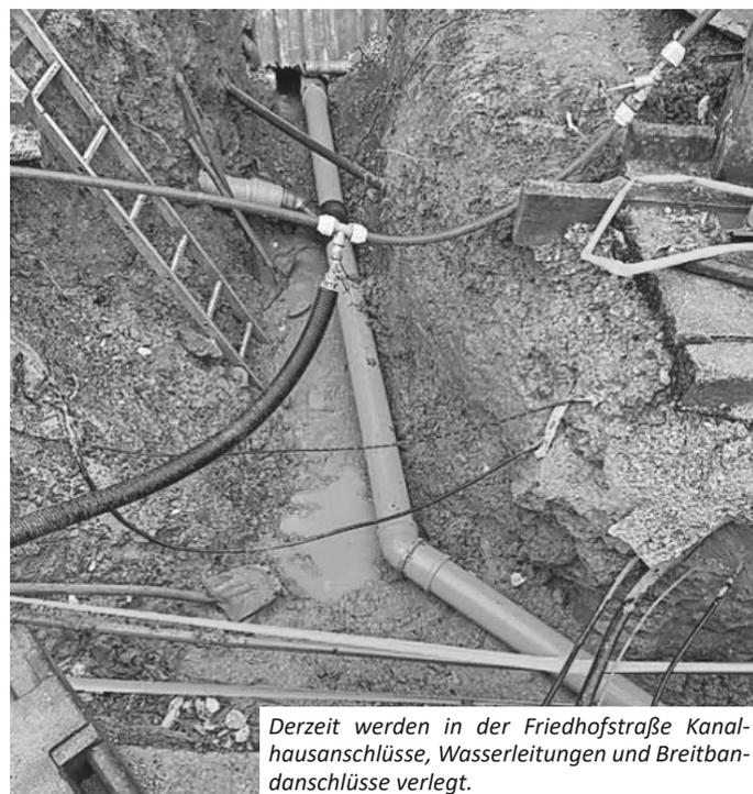
*Derzeit werden in der Friedhofstraße Kanalhausanschlüsse, Wasserleitungen und Breitbandanschlüsse verlegt.*
