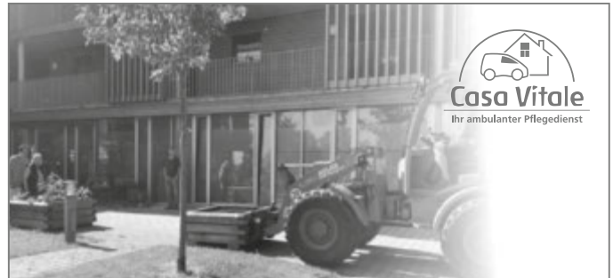
Anlieferung der neuen Gemüse-Hochbeete, bereitgestellt von der Gemeinde Mönchweiler
