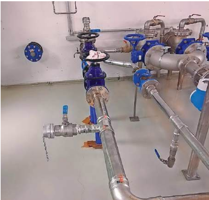
Die Arbeiten zur Erneuerung der Fallleitungen der Nieder- und Hochzone der Wasserversorgung am Hochbehälter in der Oberen Mühlenstraße wurden erfolgreich abgeschlossen.
