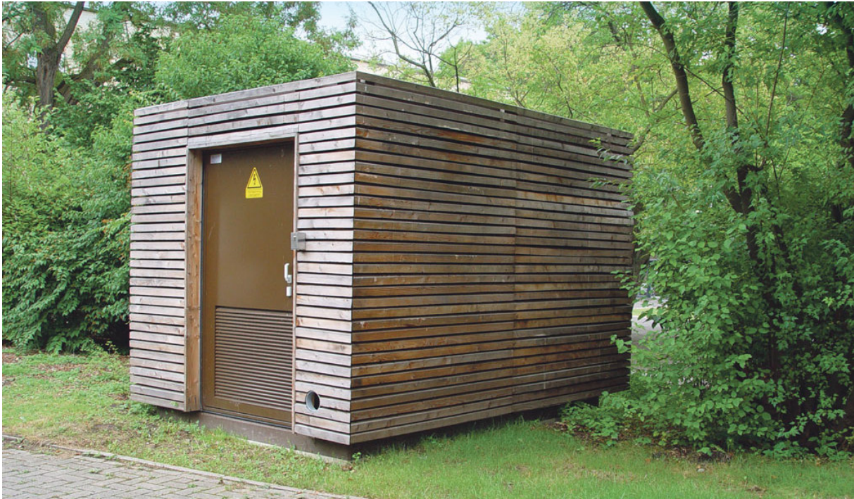
Abb. 14: Heizzentrale Quelle: © Scheidt GmbH & Co.KG.
